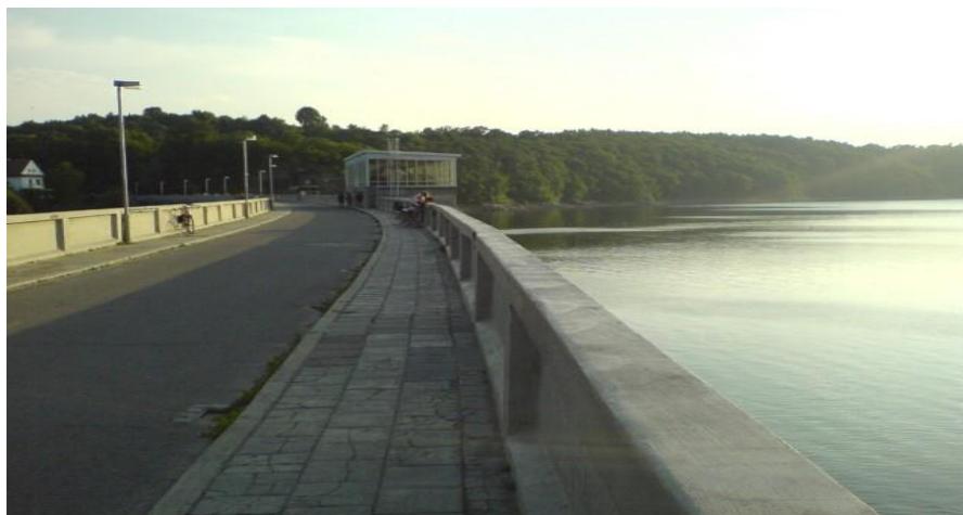
1. Vranovská přehradní hráz
