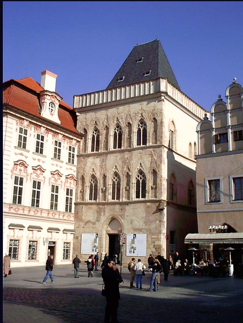
Dům u kamenného zvonu, Praha
