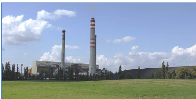
Elektrárna v Opatovicích nad Labem
